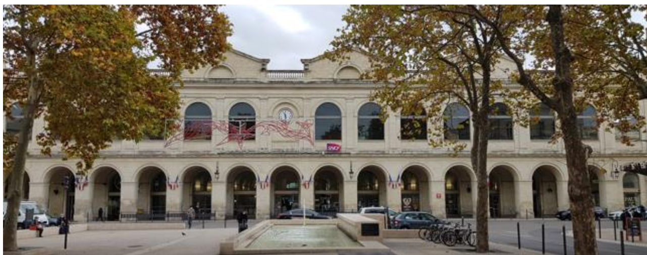
Gare de Nîmes – Photo SNCF Gares & Connexions
